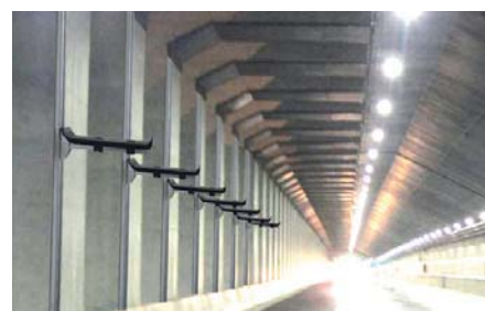
Installation des PEC Kabelhaltersystems im Tunnel
